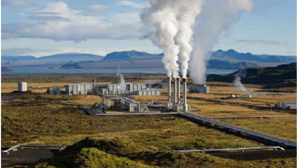
شكل (12) إحدى محطات إنتاج الطاقة الجيوصارارية.
