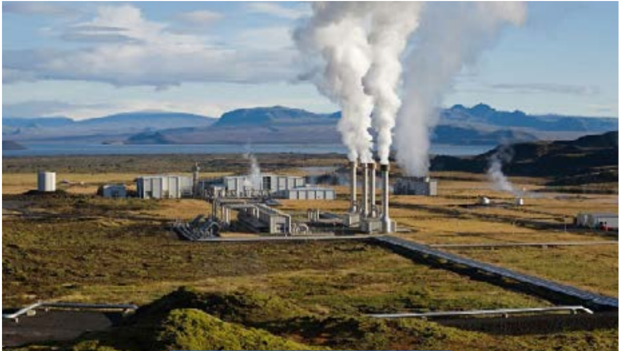
شكل (12) إحدى محطات إنتاج الطاقة الجيوتحرارية.
